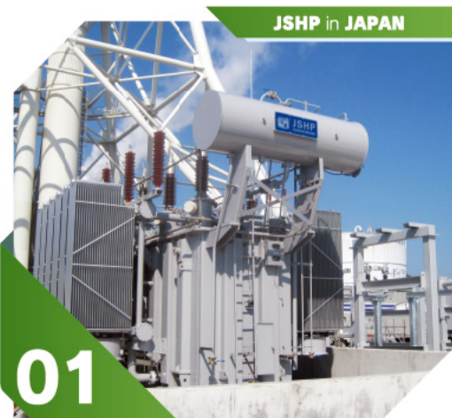
変圧器容量：100MVA 変圧器電圧：66kV/11.5kV/11.5kV 日本納品場所：横須賀火力発電所
