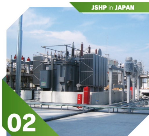
変圧器容量：100MVA 変圧器電圧：66kV/33kV 日本納品場所：横須賀火力発電所
